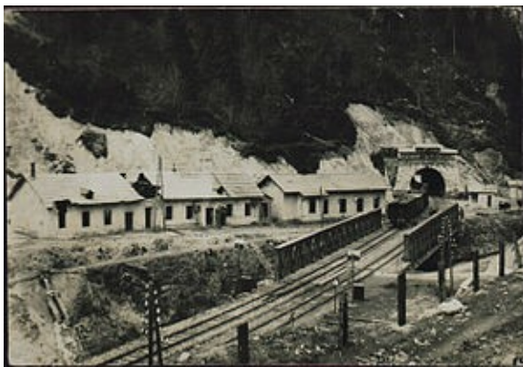
Karawankentunnel in Rosenbach Beginn der Verbauung im Mai 1919
