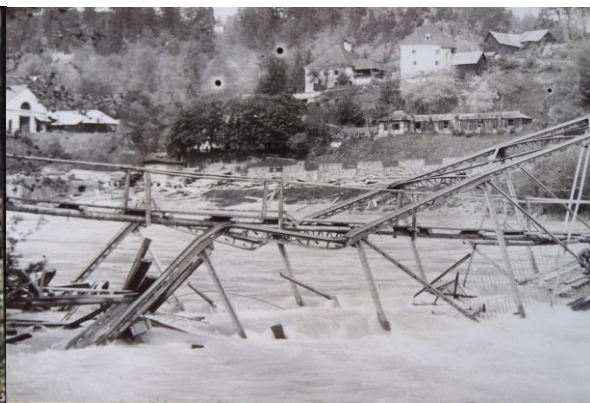
Lippitzbacher Draubrücke, gesprengt am 5. Mai 1919
